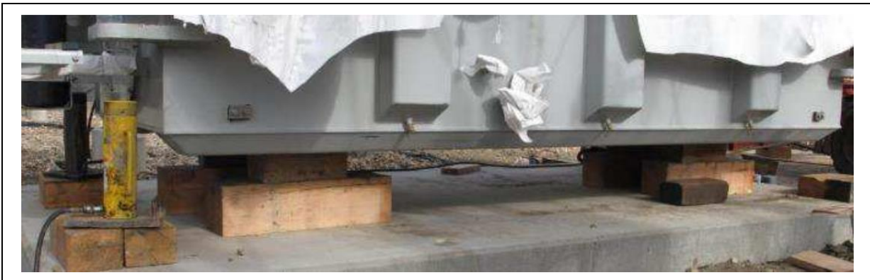
شکل (۱-۶): استفاده از بلوک‌های مهارکننده جهت مهار ترانسفورماتور هنگام کشیده شدن
